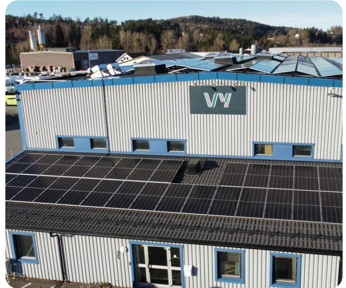
I 2024 satte vi i drift vårt første solcelleanlegg. Anlegget består av 304 solcellepaneler og er på taket til Vy buss sitt anlegg i Mysen
